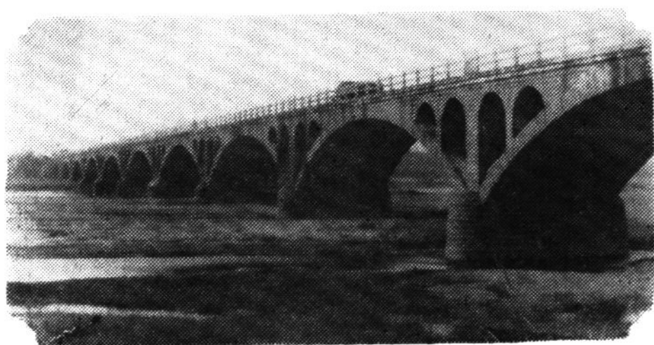
汝河公路大桥
