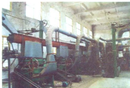
鲁溪轧花厂剥绒车间
