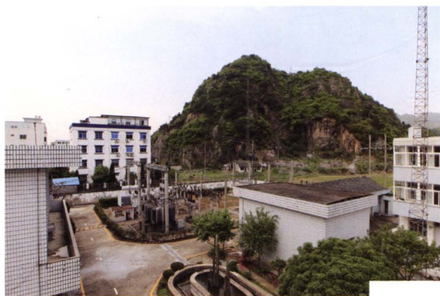
1994年4月投运的35千伏乌牛变电所
