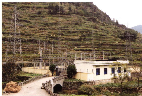
1995年1月投运的35千伏大岙变电所
