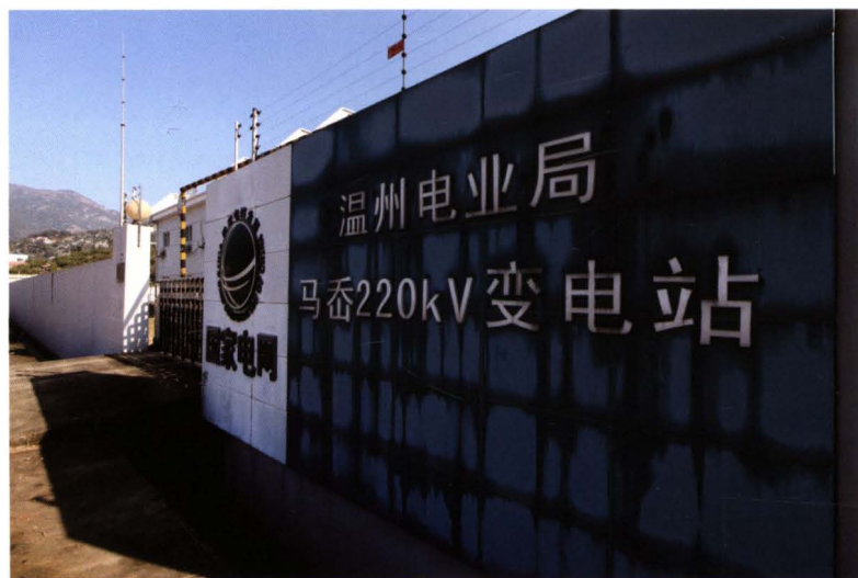
2007年11月投运的220千伏马岙变电站
