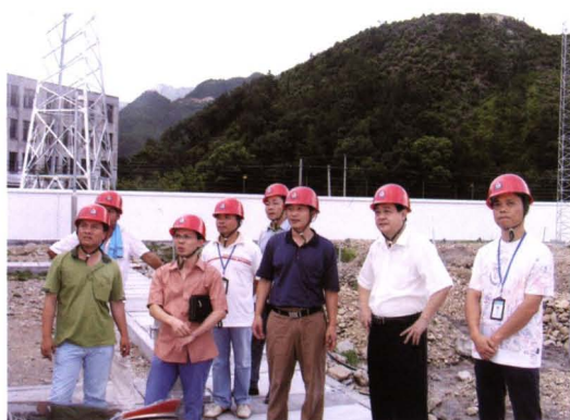
2006年7月12日，温州电业局党委副书记、纪委书记薛公木（右三）到35千伏徐岙变电所施工现场指导工作
