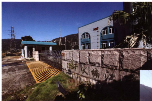
2001年7月投运的220千伏楠江变电站
