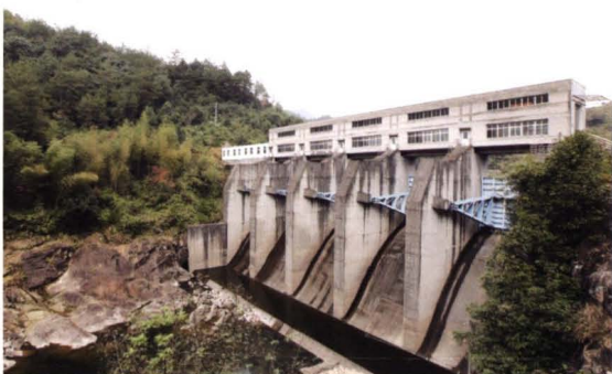
北溪二级电站水库大坝
