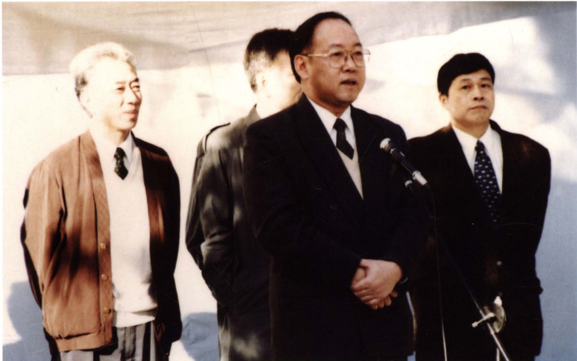
1996年11月13日，浙江省暨华东电网行政村村村通电庆典仪式在永嘉县黄南乡王山村举行。图为浙江省电力工业局副局长陈积民宣布合闸通电
