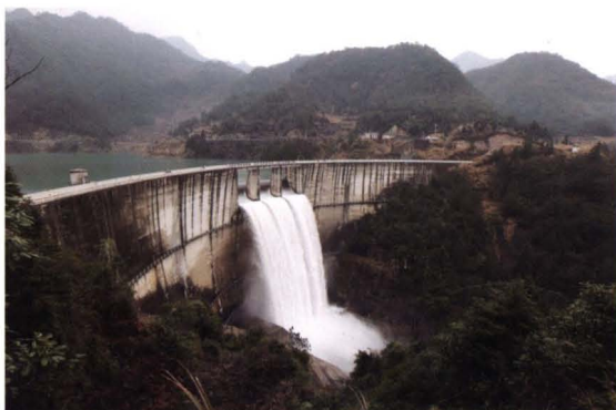
北溪电站水库大坝
