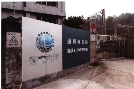
1996年12月投运的110千伏菇溪变电站
