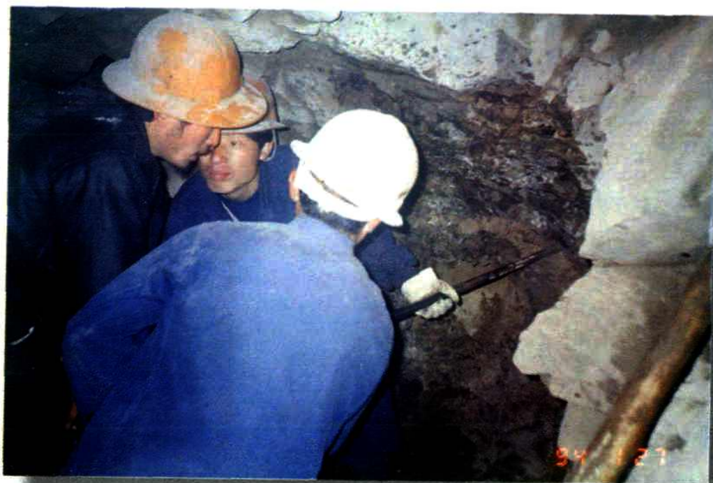
铁路建设工人正在隧道洞中施工
