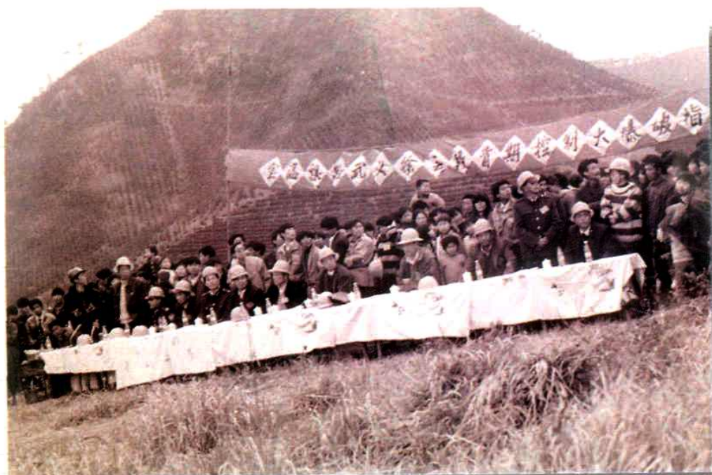
武义徐主村地段控制大爆破指挥部
