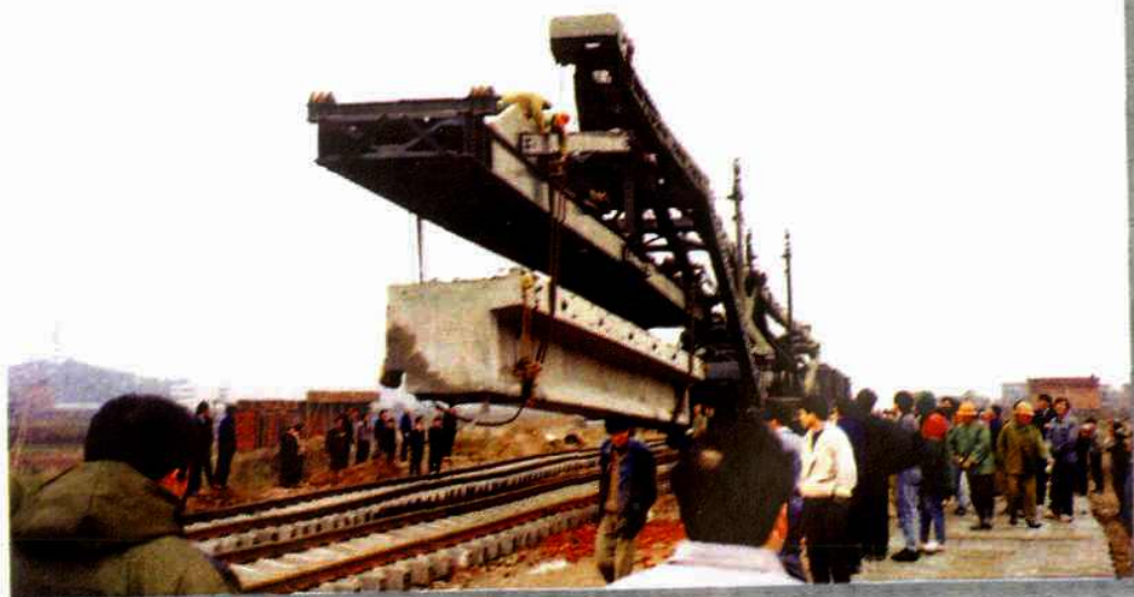
武义段工地机械化施工
