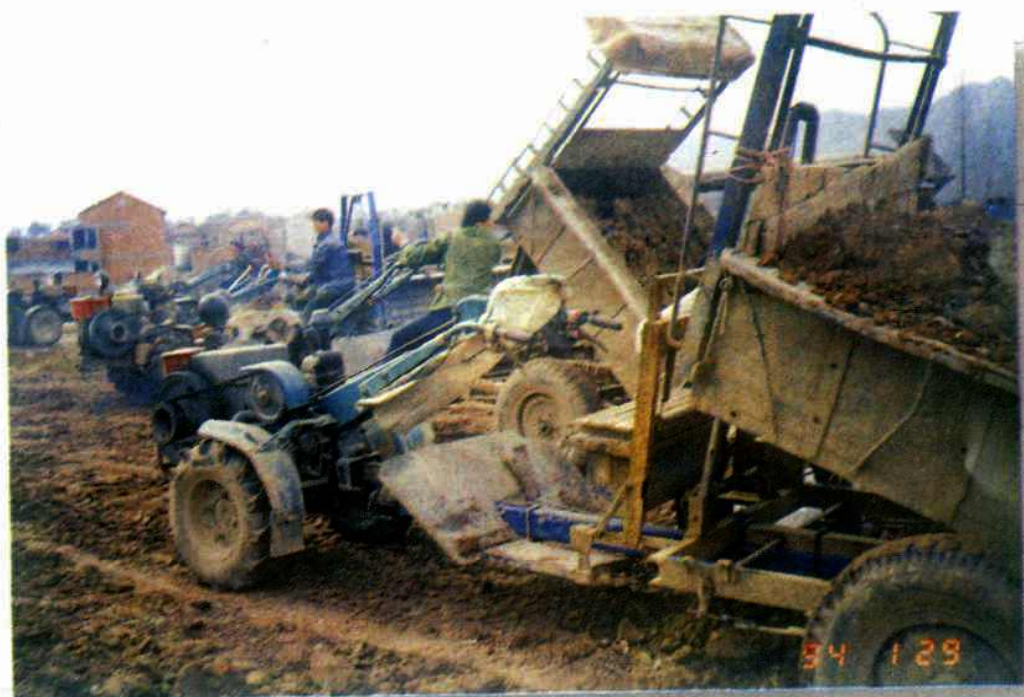
武义段工地手扶拖拉机运土
