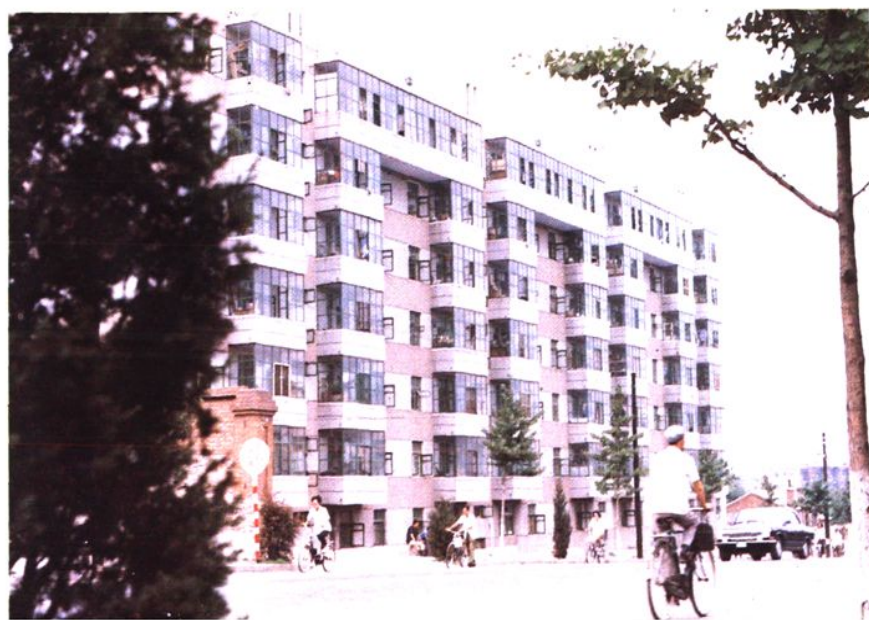
← 位于北京路3段南侧的职工住宅楼
