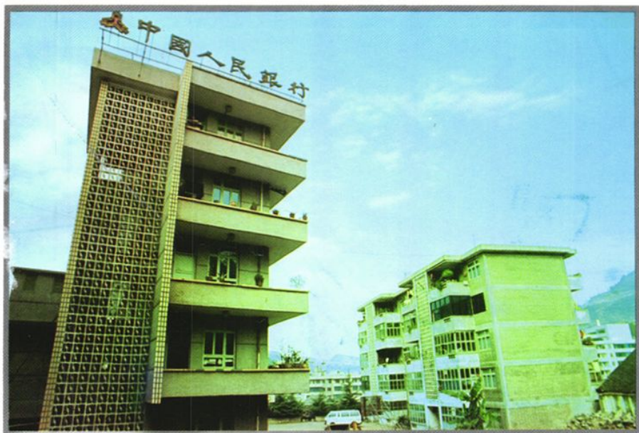
1990年建成的人民银行办公大楼
