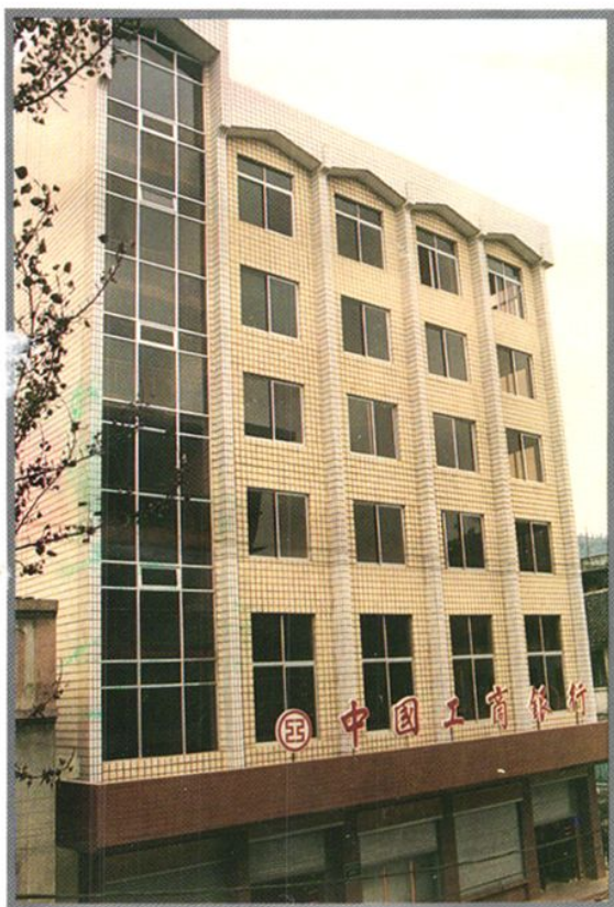
1989年建成的工商银行办公大楼
