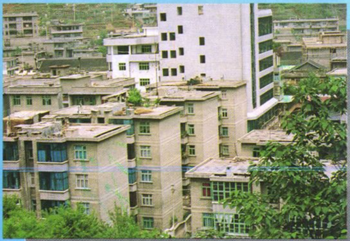
盘特建行支持房地产开发公 司新建的商品房小区
