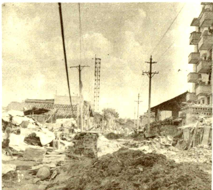
地处河边 县级机关、路 面、电讯设备 被淹损情况
