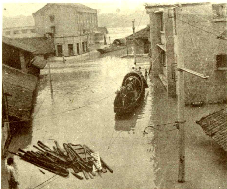
地处河边 县级机关房屋 被淹没情况 (李吉德摄)
