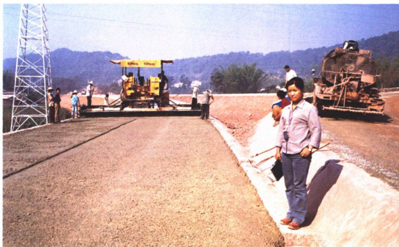
技术人员对施 工路面检查 (毛智生 摄)
