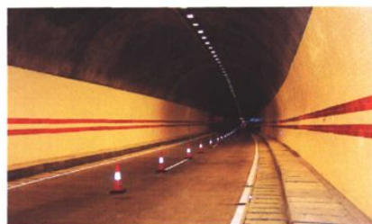
元磨高速公路隧道 (杨志坚 摄)
