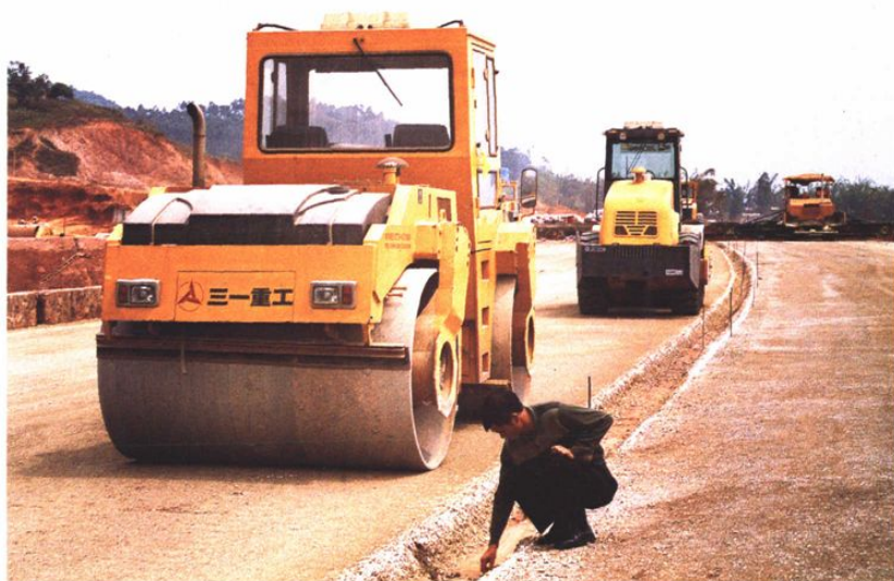
机械化施工的 路面 (毛智生 摄)
