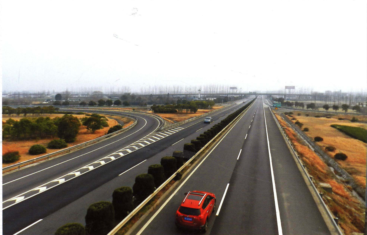
宁盐高速公路
