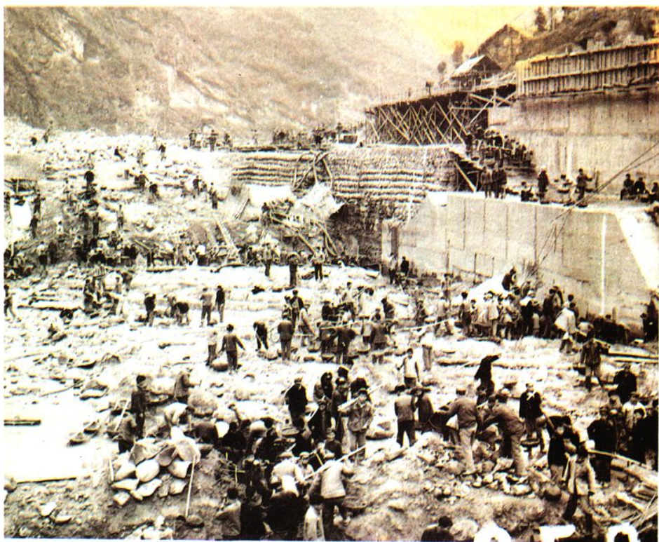
上：1978年，三坝电站大坝施工现场。
