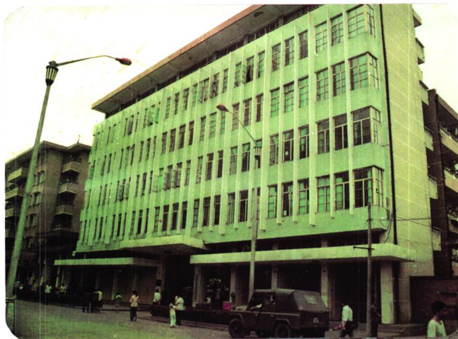
▲ 县电力公司办公大楼
