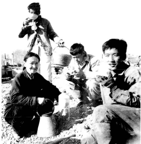
在电厂建设中不少群众义务为建设者服务。图为一位老大娘义务为工地送开水
