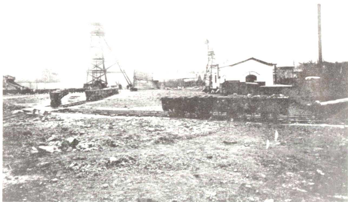
1922年建成的四亩墩二号新立井
