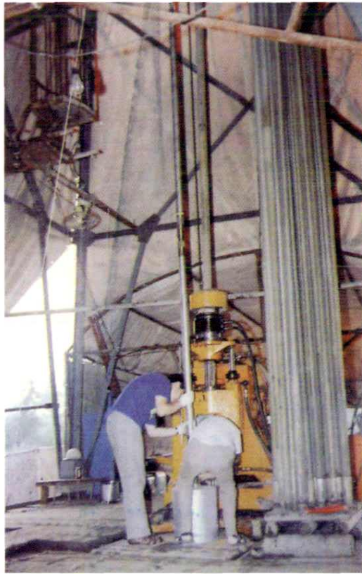
浙江省煤田地质勘探公司职工正在进行钻探施工
