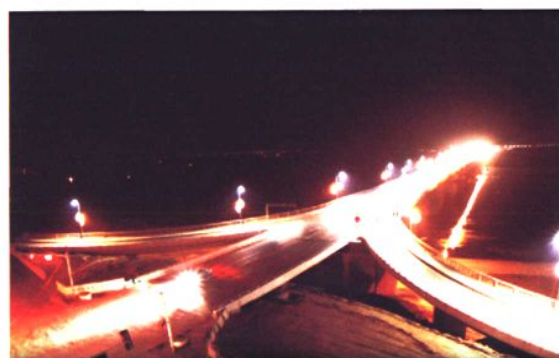
▲ 南水北调施工大桥
