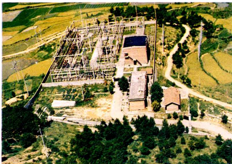
零陵電業局自行安裝的冷水灘陳家山 110 千伏變電站，1983 年建成。
