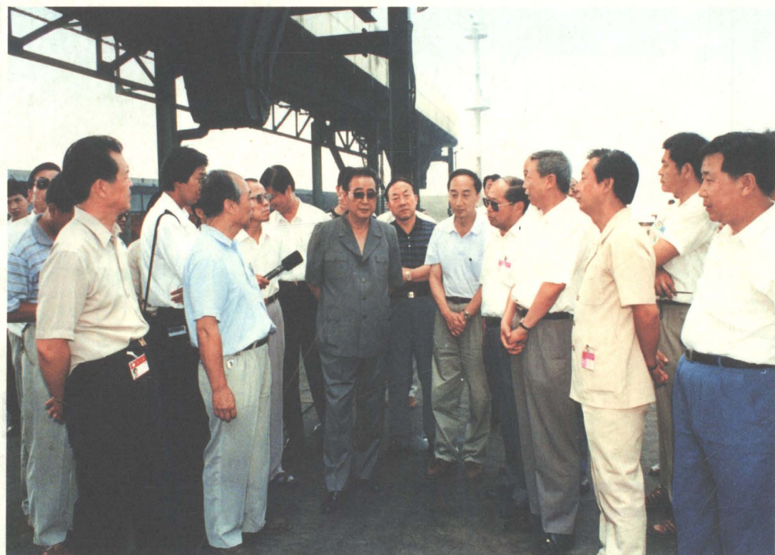
1996年8月16日，国务院总理李鹏（右八）视察秦皇岛港煤码头四期工程。
