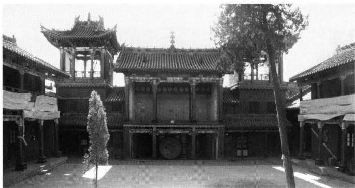
泽州县辛壁村成汤庙舞楼
