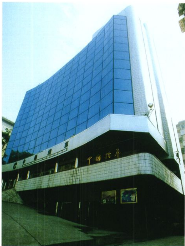
自贡烟草分公司办公大楼
