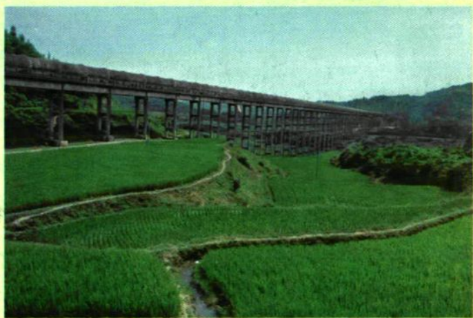
▲ 新安铺倒虹吸管桐木坨排架桥
