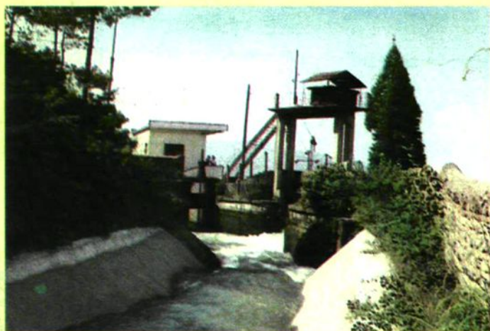
▲ 红旗水电管理站云里坳倒虹吸管进口闸门
