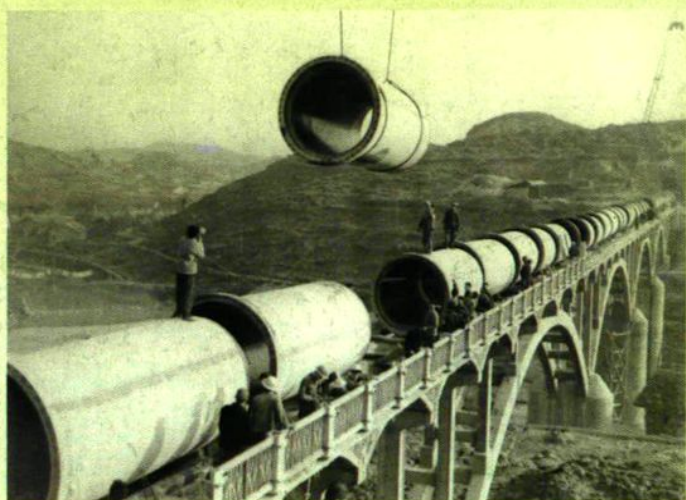
▲ 1977年新安铺倒虹吸管安装现场
