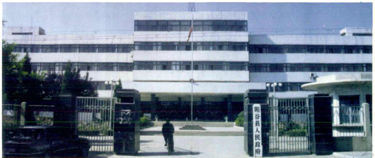
▽ 阳谷县政府办公楼
