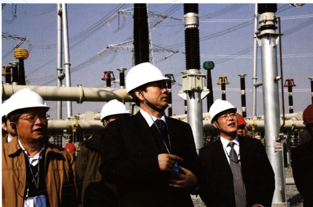
2007 年 11 月 19 日，时任国家电网公司副总经理郑宝森（前中）视察 500 千伏锡西南变电站工地
