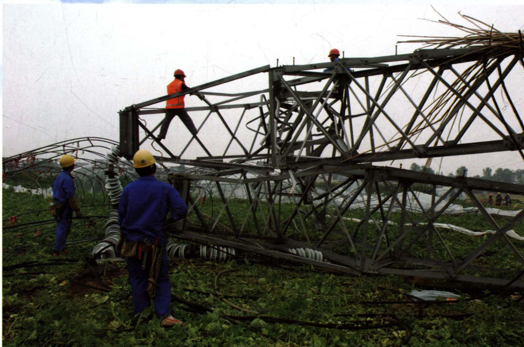
2011 年 6 月 500 千伏江晋线抢修
