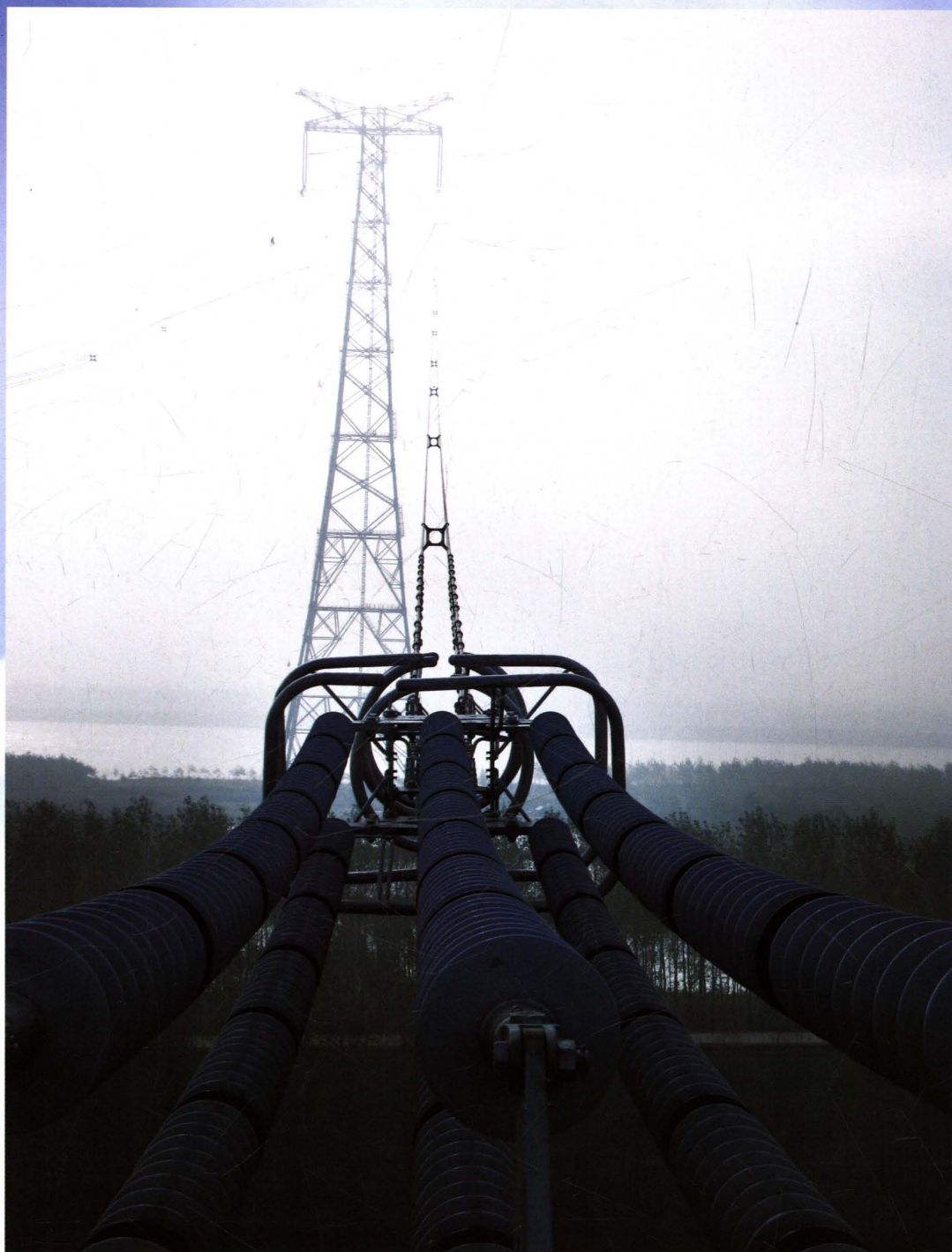
锦屏-苏南±800 千伏特高压直流输电线路工程 K2 大跨越
