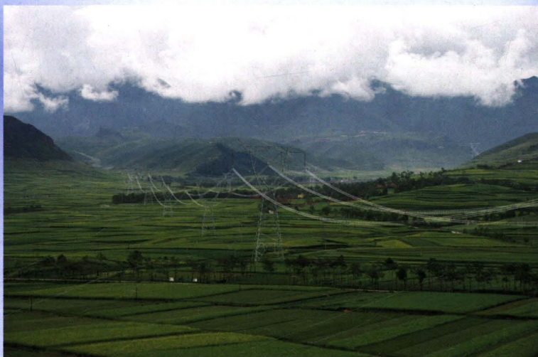
750 千伏拉西瓦-西宁输电线路工程
