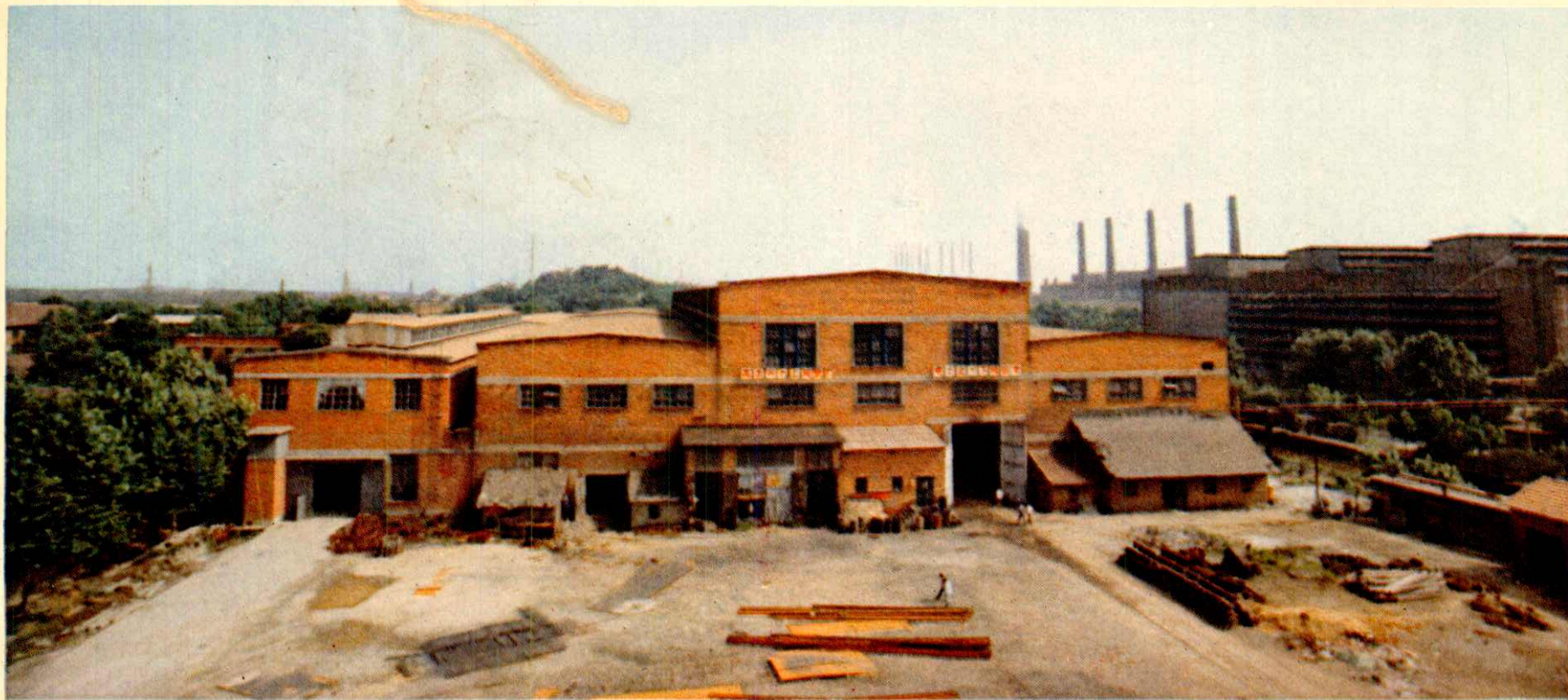
主体车间全景
