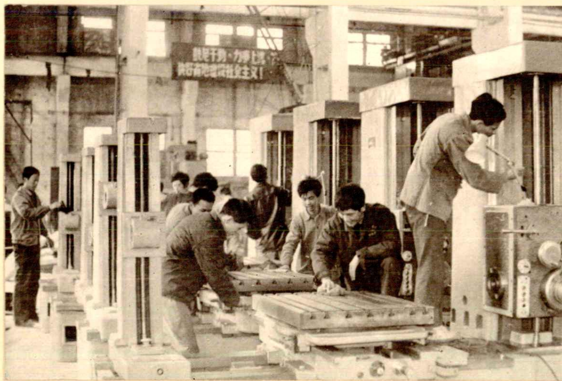
设备科钳工班正在维护机床
