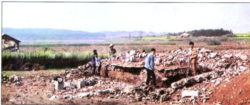
违法占地建筑被拆除
