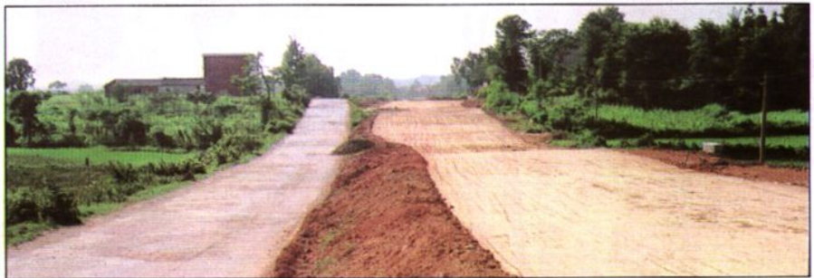
206 国道拓宽改造工程
