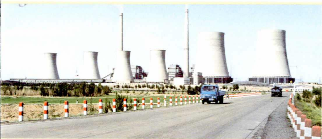
大运、大塘公路在大同第二发电厂交汇
