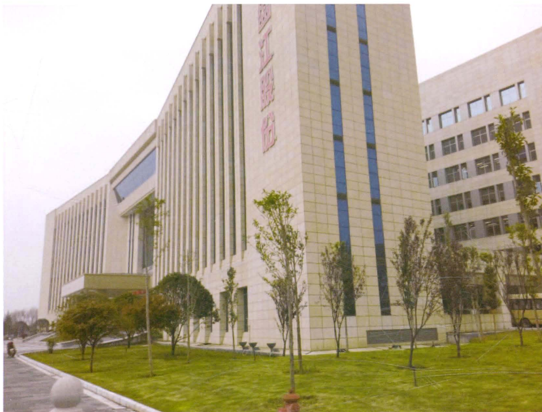
盘江精煤股份公司办公楼（2013年摄）
