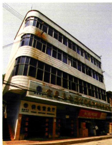
长潭河供电所
