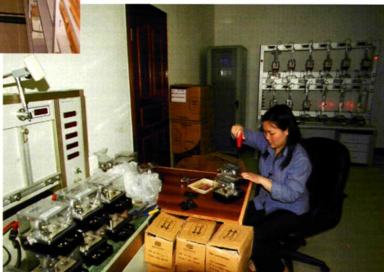
县电力公司电能计量所
