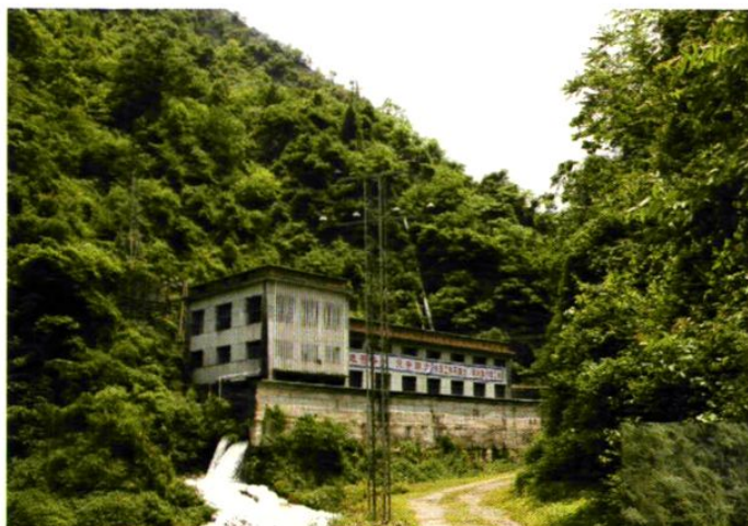
龙头沟二级水电站
