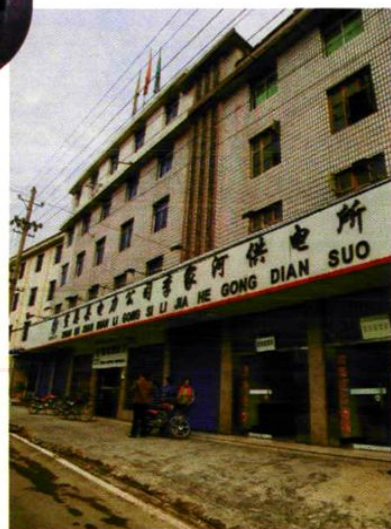
李家河供电所
