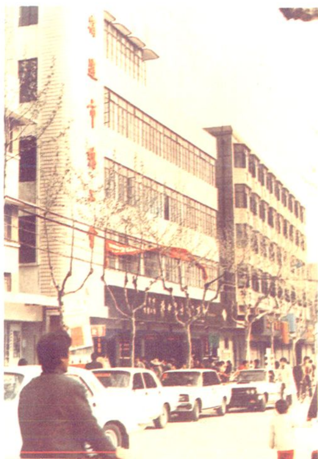
宿迁市总工会大楼
