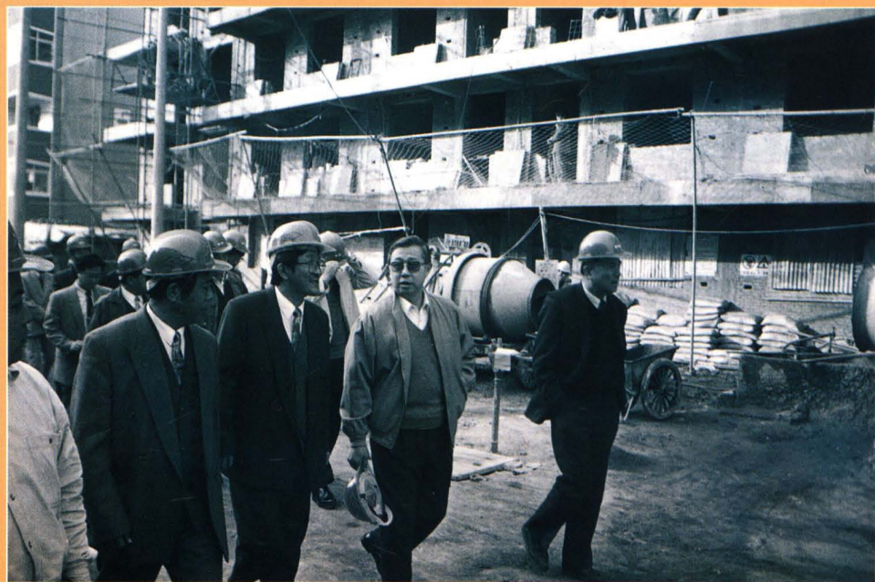
市政协领导视察安居建筑工地
