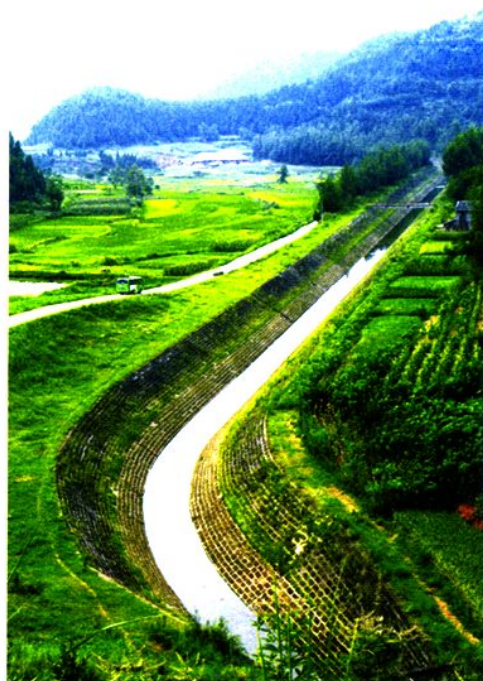
升钟水库右总干渠西充段
