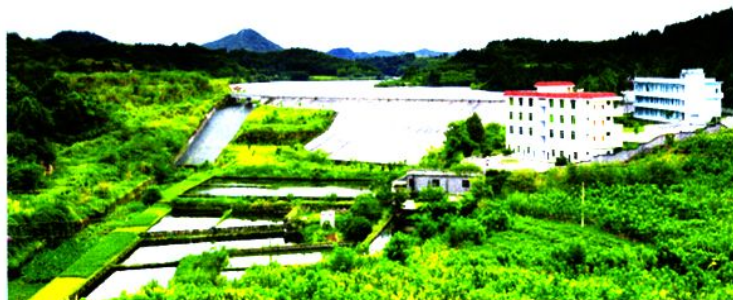
除险加固后的红旗水库大坝
