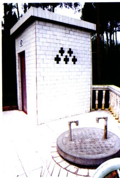
安饮工程联户井 (自来水工程)
