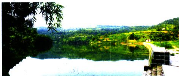
除险加固后的贾家沟水库
