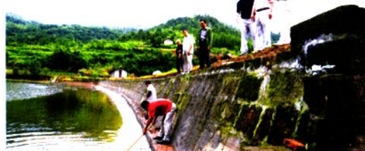
病险水库整治施工现场
