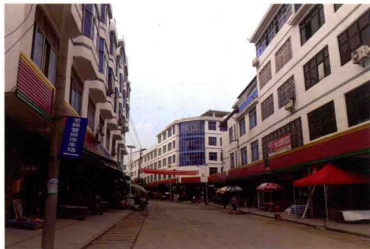
街景改造提升工程
