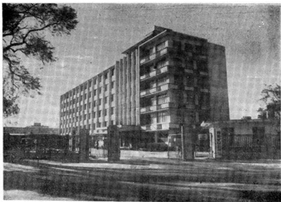
瑋春矿区建设指挥部办公楼
