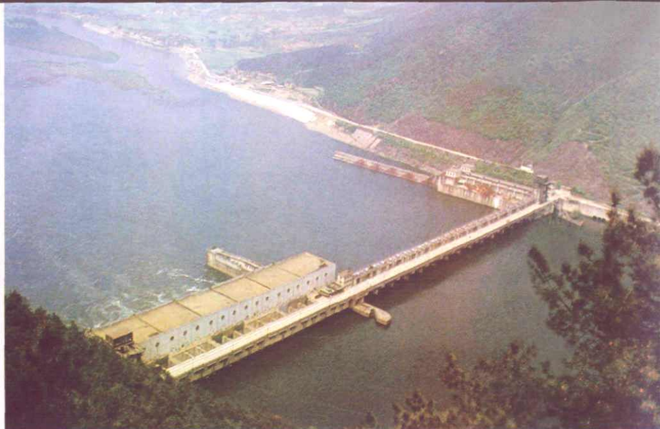
富春江水电站
