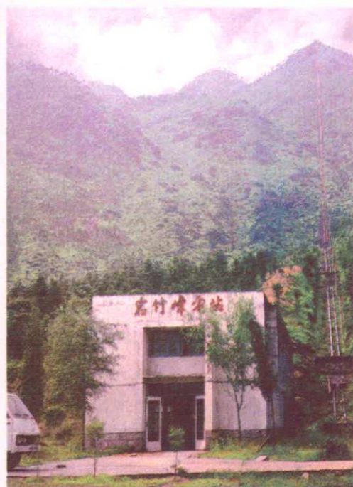
临海岩竹峰水电站（水头 484 米）
