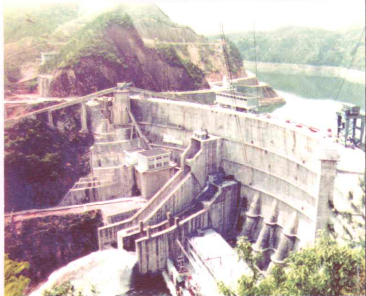
紧水滩水电站
