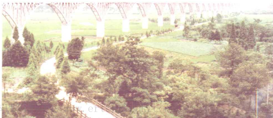
永康杨溪水库 灌区渡槽
