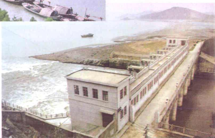
杭嘉湖南排工程长山闸
