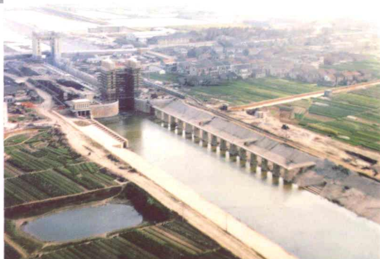
京杭运河钱塘江沟通工程三堡船闸
