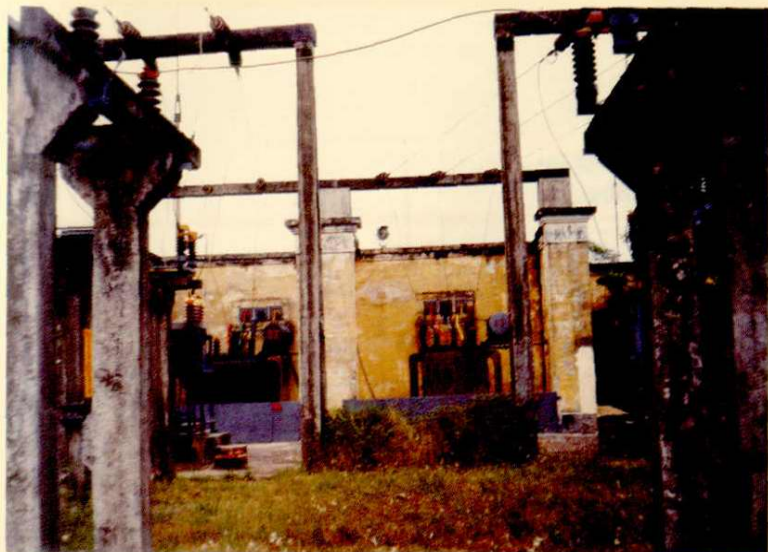
1958年7月投产的花县第一座 变电站——35千伏电台变电站
