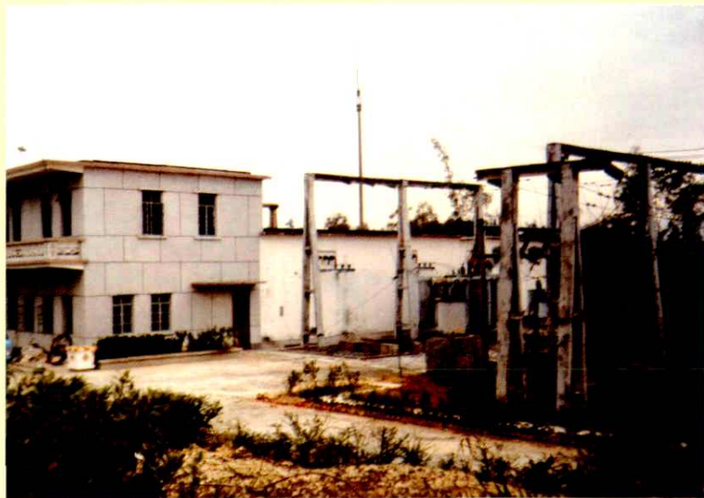
花县供电公司1976年投 产的35千伏花山变电站
