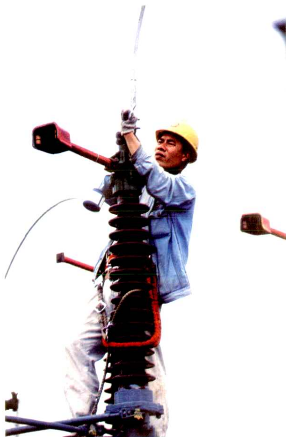
变电检修人员进行110千伏设备停电检修工作
