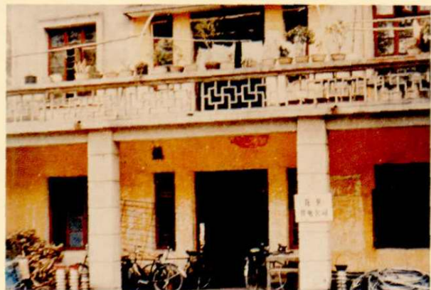
60年代中期的花县供电 公司办公楼（新中路5号）
