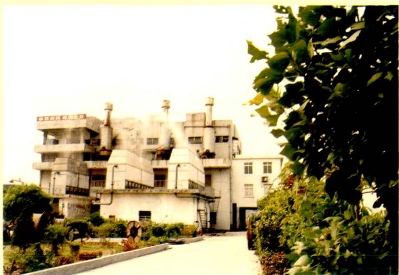
1986年12月起投产的花县 地方火力发电厂——巴江电厂 (含A、B、C厂及华辉厂)， 至1996年装机15台，总装机容 量为17.145万千瓦
