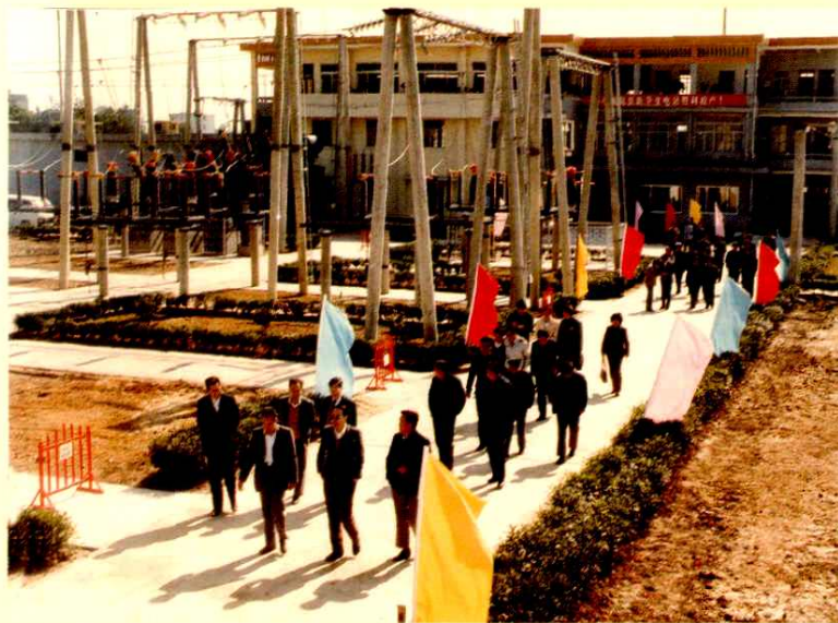
1986年12月19日，110千伏新华变电站投产，广州市副市长雷宇（前排右二）到场参加庆典仪式
