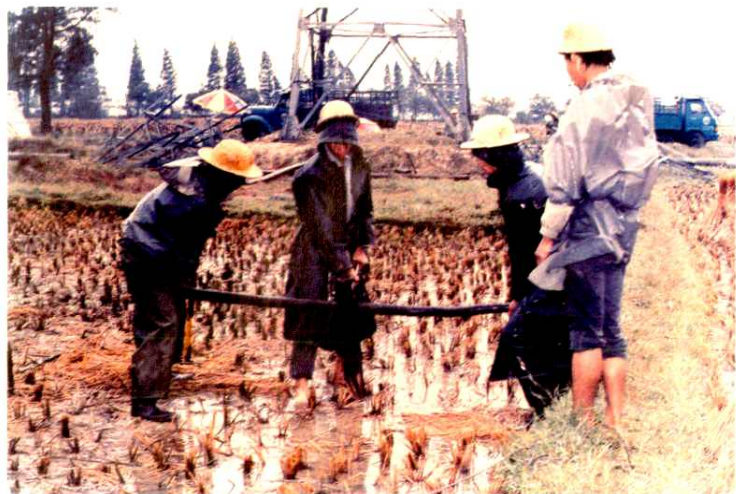
80年代初期，花县供电局线路工人野外冒雨作业现场
