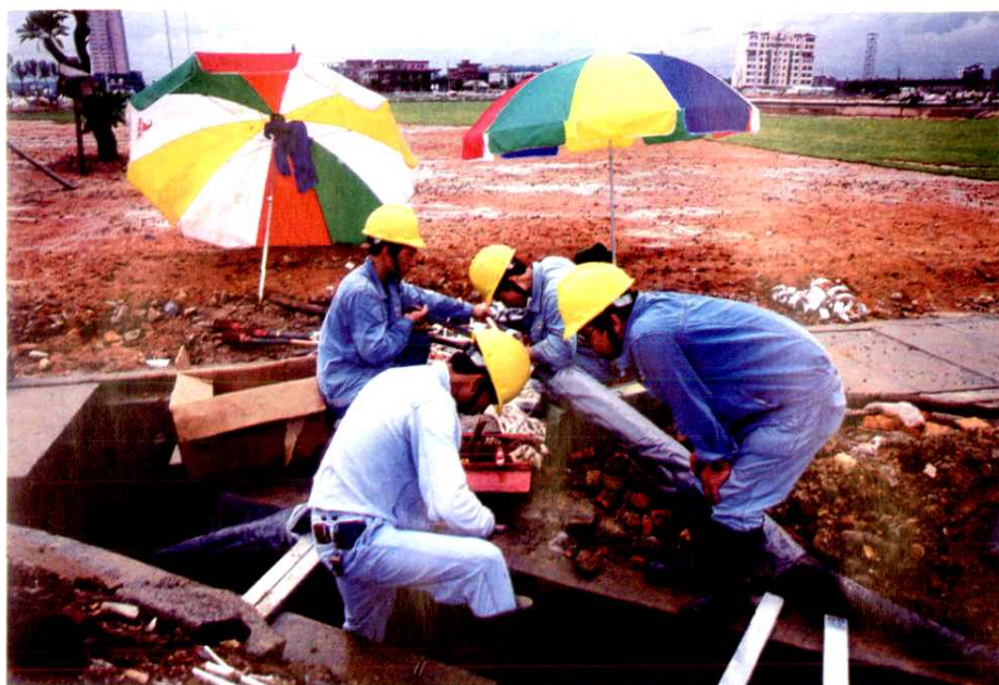
花都局电缆职工在10千伏电缆施工现场工作
