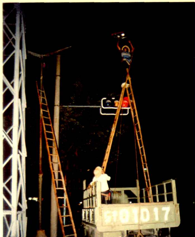
90年代初期花县路灯所职工进行路灯维修作业
