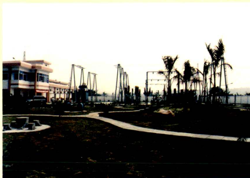
1998年9月，花园式变 电站——110千伏湖畔变 电站建成投产
