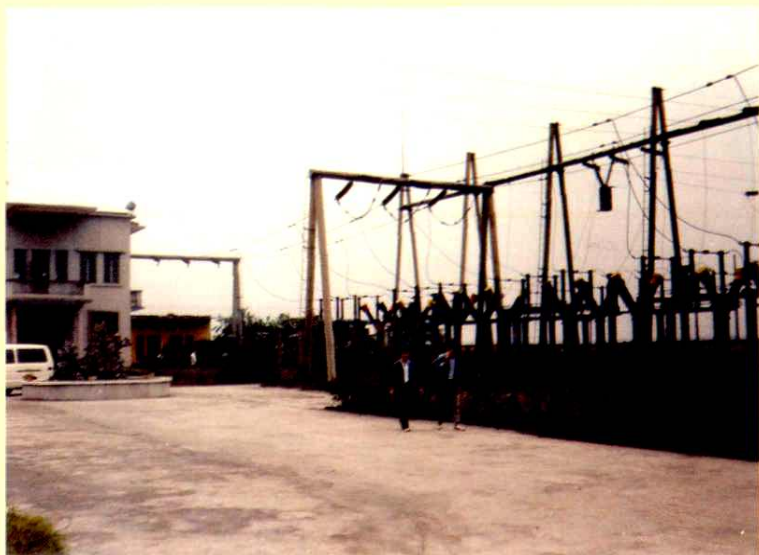
1962年6月为35千伏、 1977年升为110千伏的花县 松仔岭变电站
