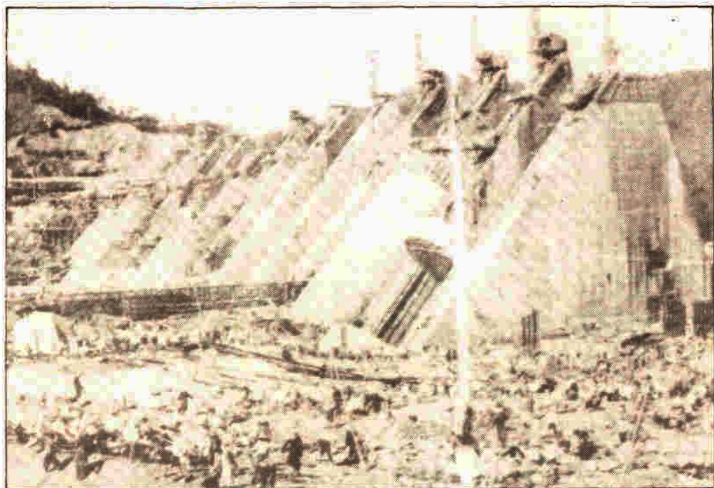
建造中的佛子岭连拱坝
