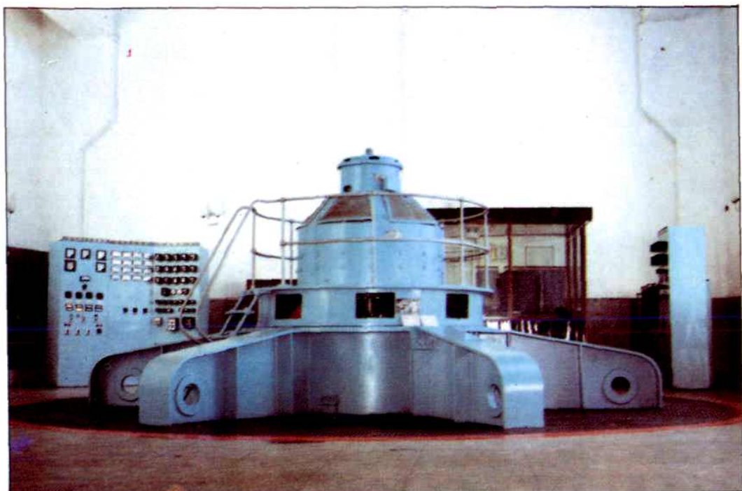
磨子潭分站水轮发电机组
