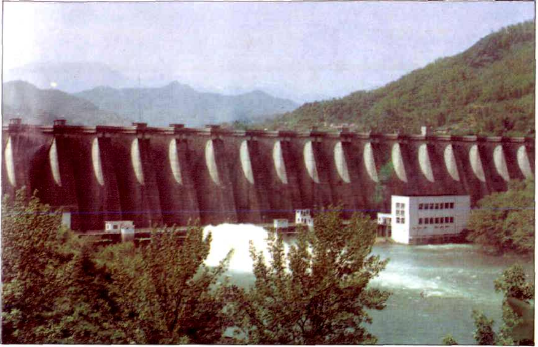
佛子岭水库连拱坝
