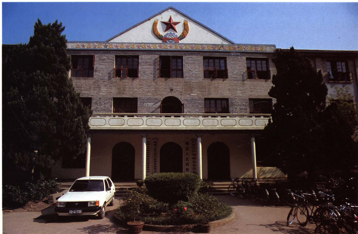
▲县级机关办公楼（1985年）
