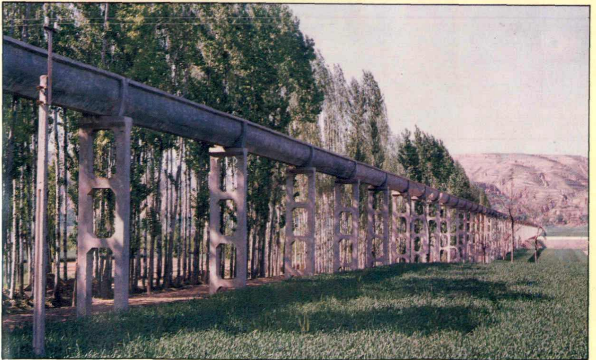
王村南水北调工程
