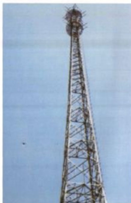
峪山移动通讯信号接收塔
