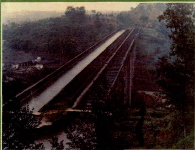
▲ 东风渠鸡公嘴大渡槽
