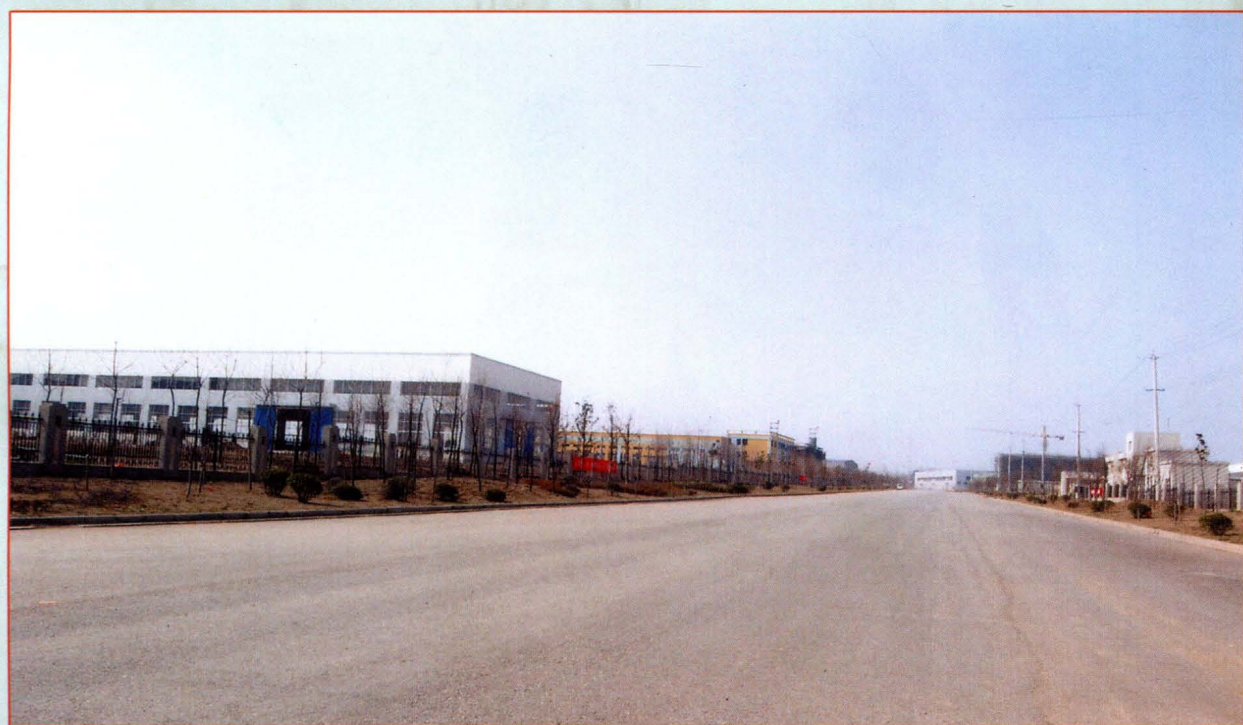
建设中的桥林工业园区
