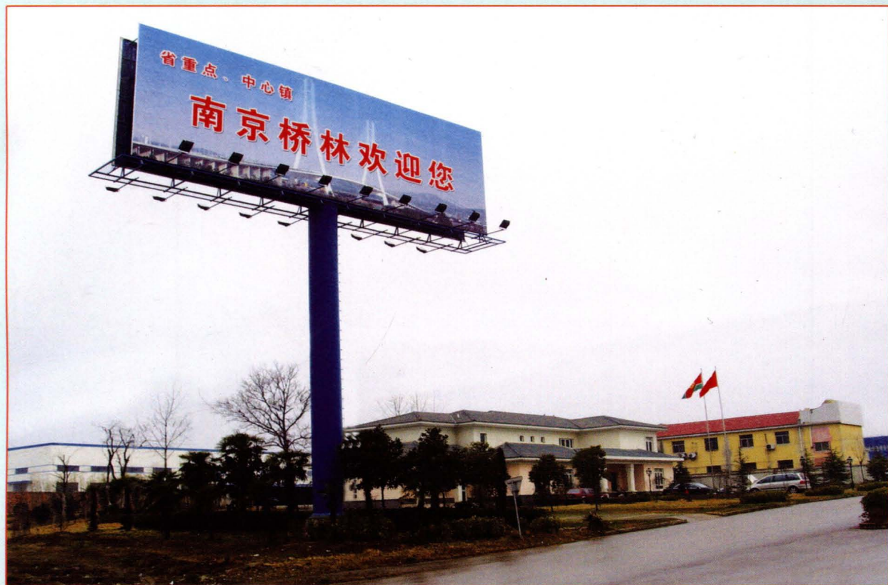
桥林镇工业园管委会办公楼
