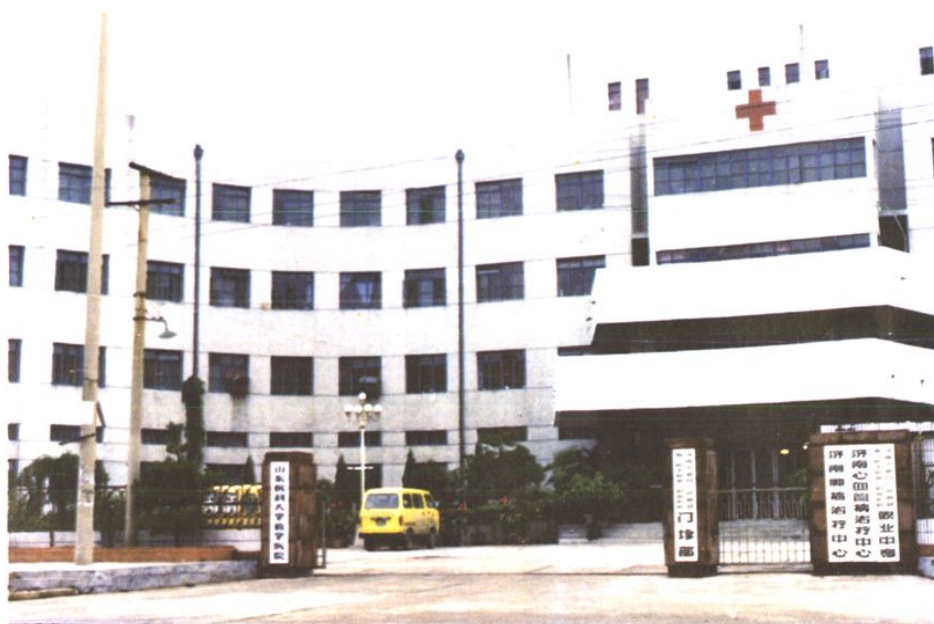
▲ 1990 年 4 月建成的门诊大楼
