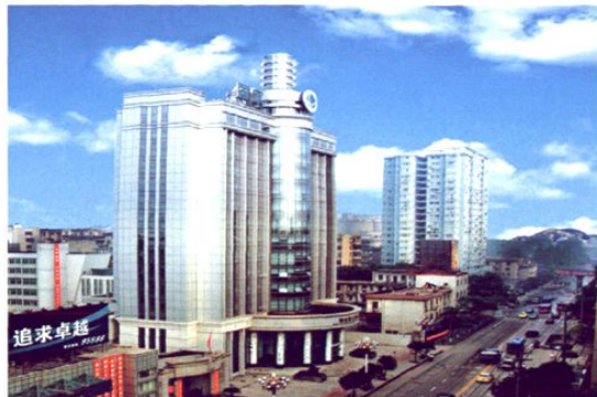
▲ 黄石供电大楼
