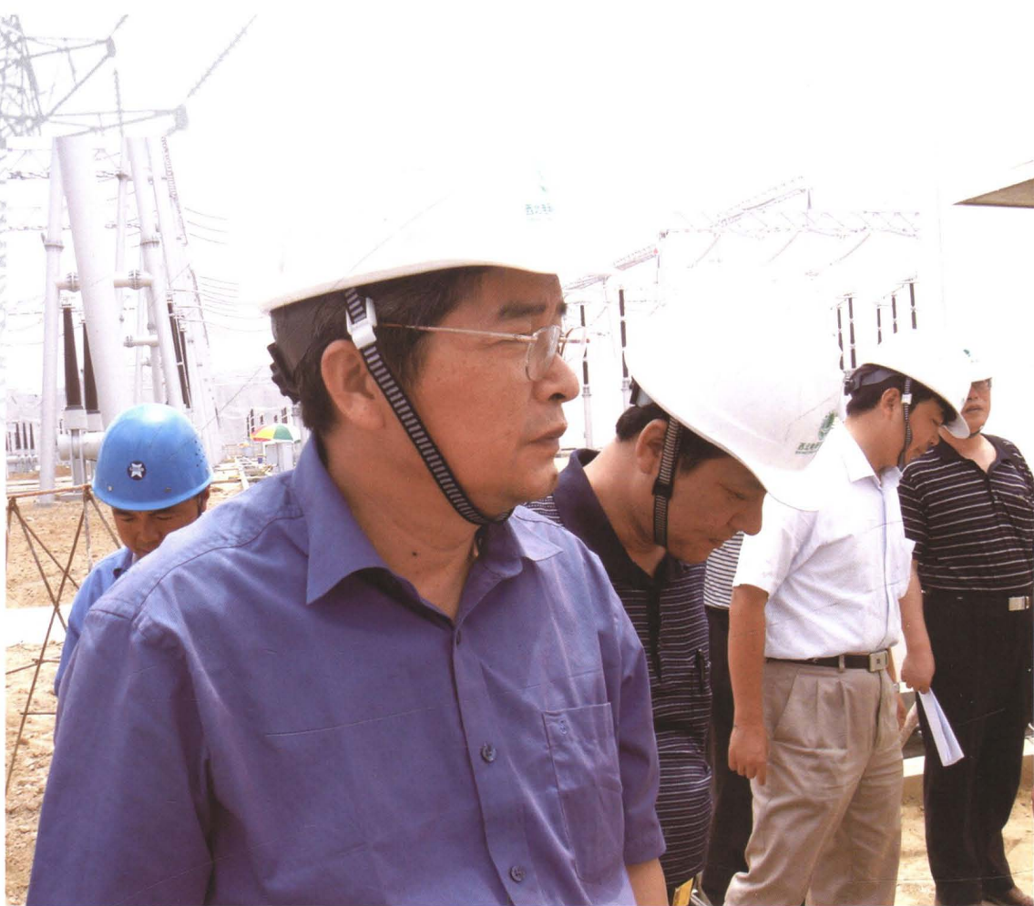
2006年6月29日，国家电网公司顾问（副部级）刘本粹（左1）视察750千伏兰州东变电站工地
