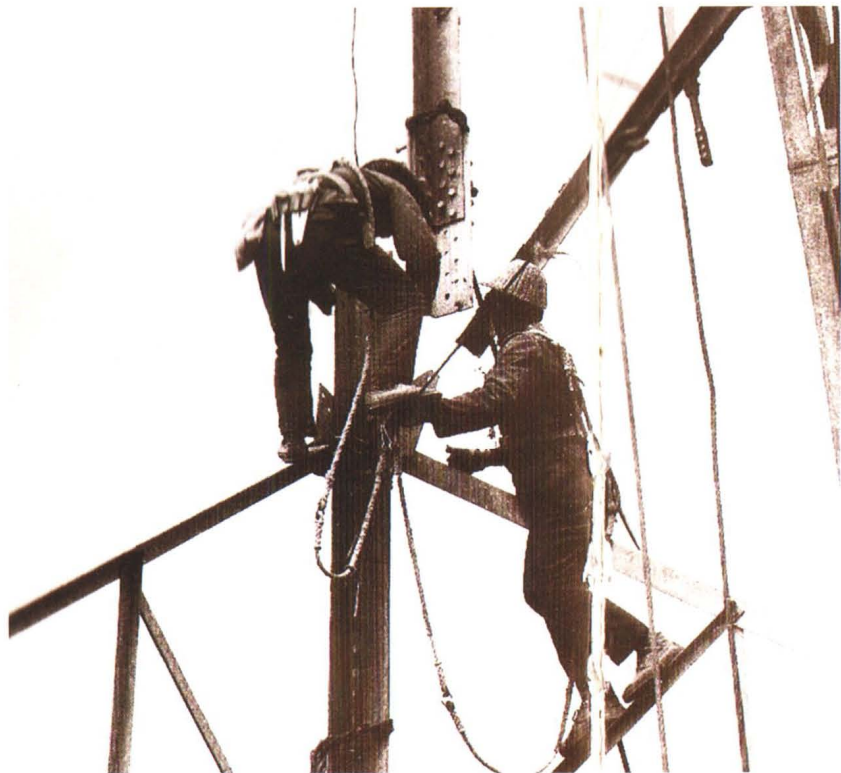
1960年代的送电施工现场，高空作业人员头戴柳条安全帽
