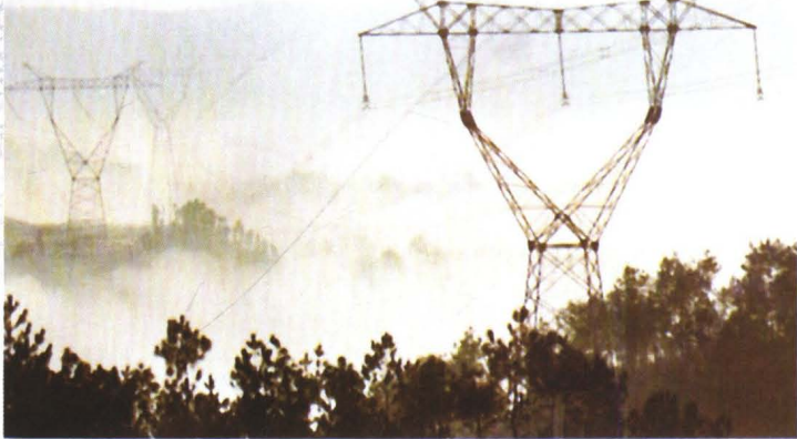
1981年建成的500千伏平顶山—武昌送电线路
