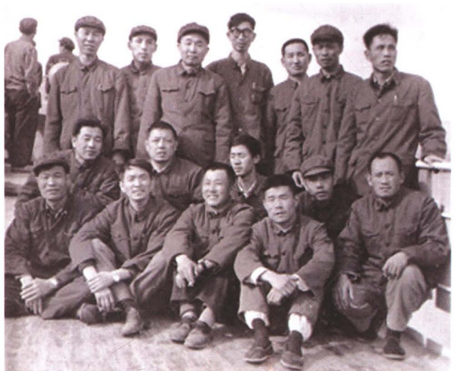
1975年在220千伏连城—永昌送电线路施工的部分员工
