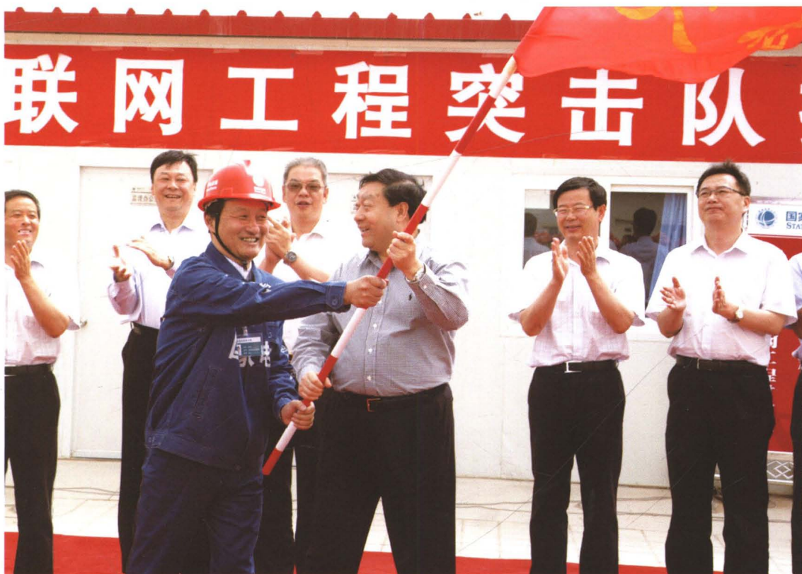
2010年8月26日，国家电网公司党组书记、总经理刘振亚（右3）和酒泉市委书记李建华（右2） 视察750千伏新疆—西北联网工程敦煌变电站工地，为该变电站工程突击队授旗
