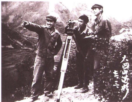
1971年公司员工在110千伏四川万源—陕西紫阳送电线路施工
