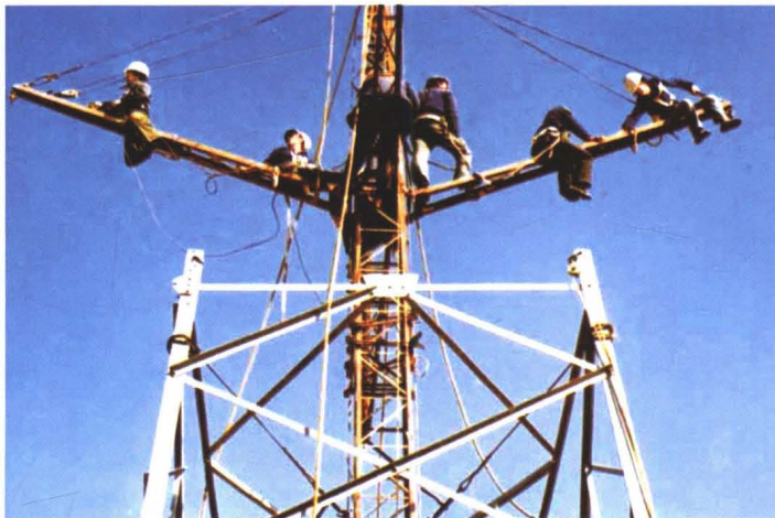
在500千伏平顶山—武昌送电线路施工中开发应用落地式摇臂抱杆组立铁塔工艺
