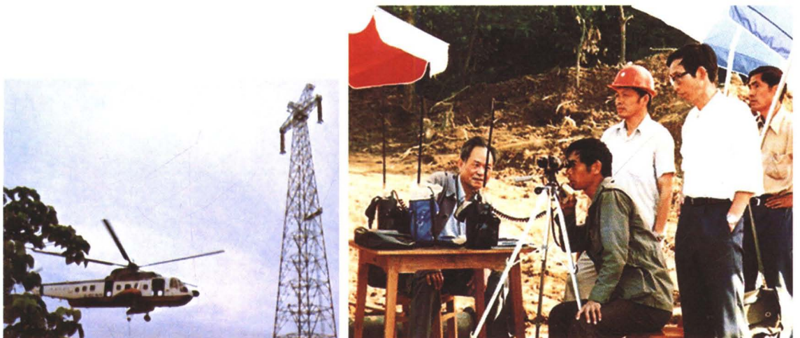
1986年公司员工在 \pm 500 千伏葛洲坝—上海直流送电线路施工现场施工，首次在国内采用直升机放线。
