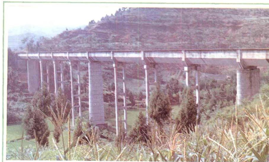
▲ 钢筋混凝土排架桥儿河渡槽
