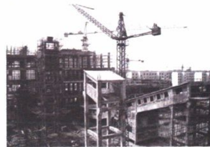
建设中的原煤运输栈桥
