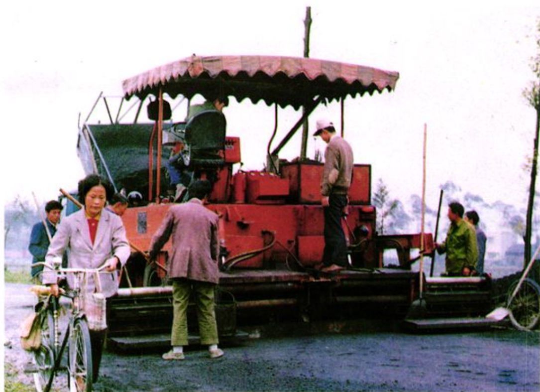
机械沥青路面铺设乡村公路施工现场
