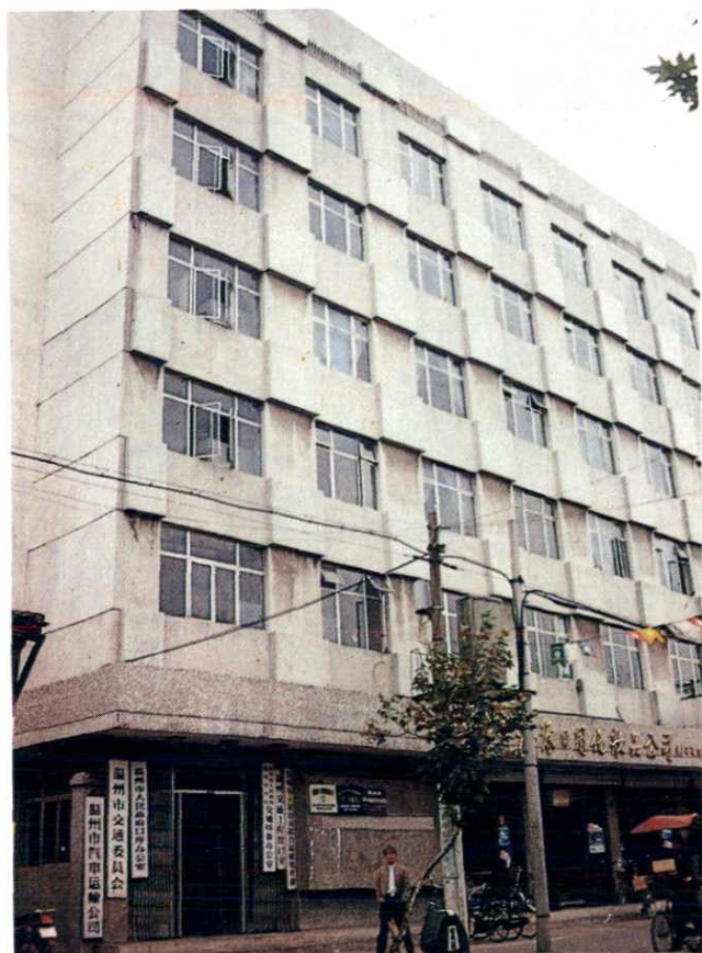
温州市交通委员会大楼
