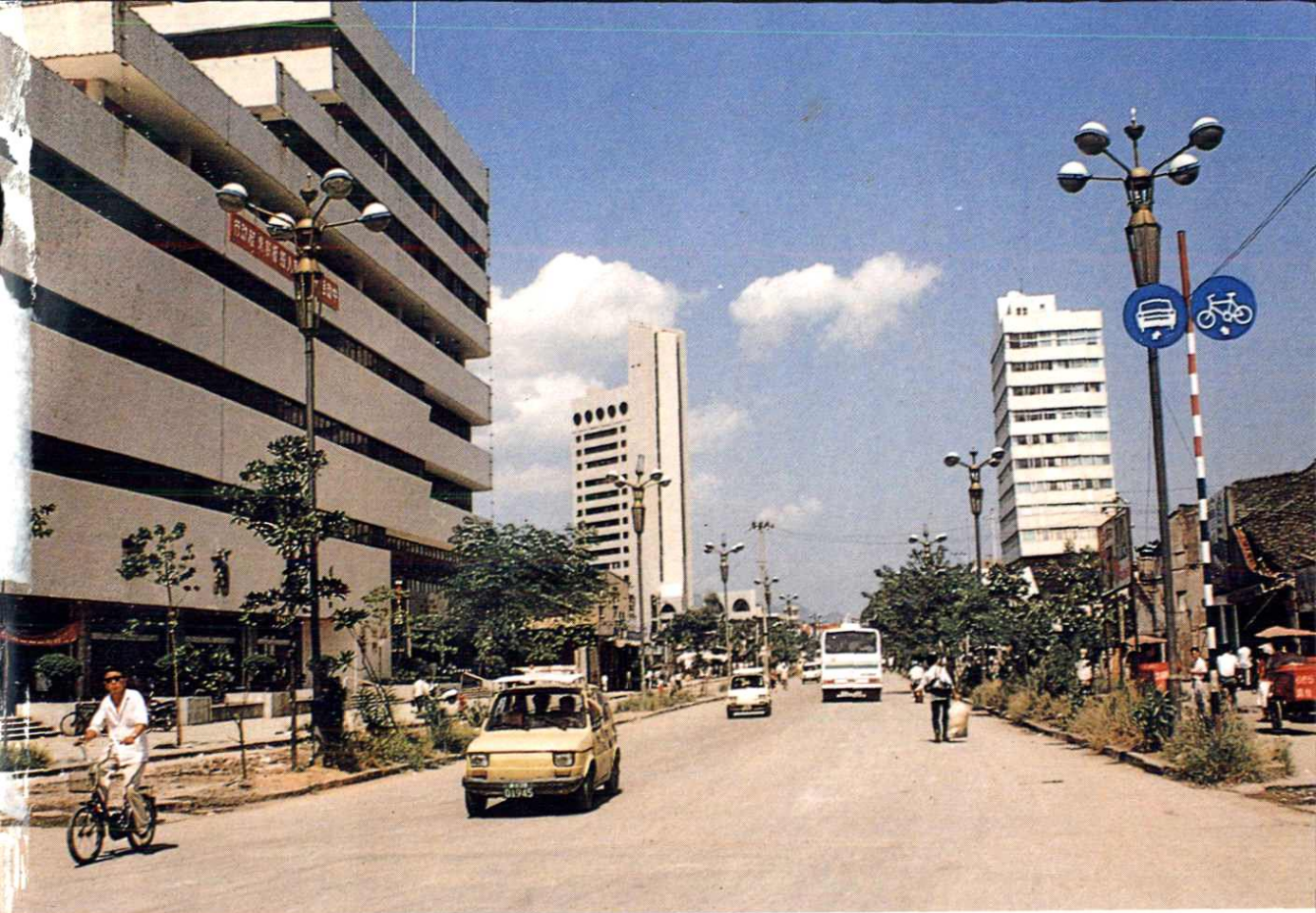
扩建中的鹿城区人民东路
