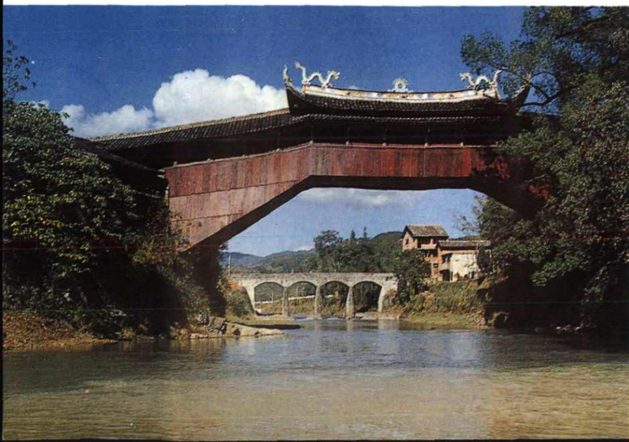
泰顺泗溪北涧桥
