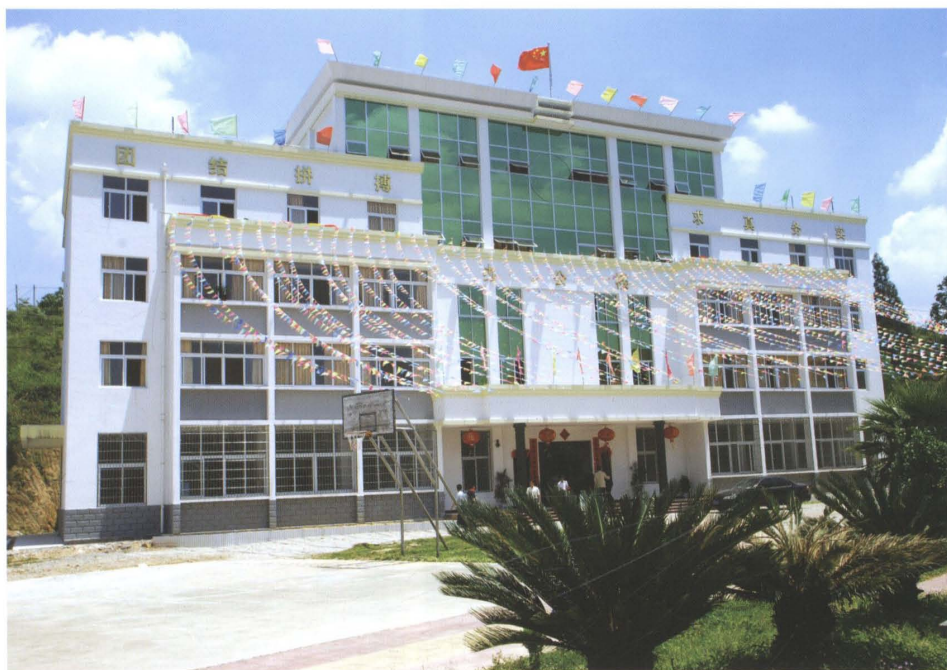
石苍乡政府办公大楼
