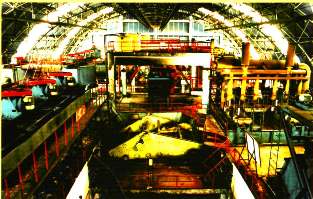
屯兰矿选煤厂主洗车间
