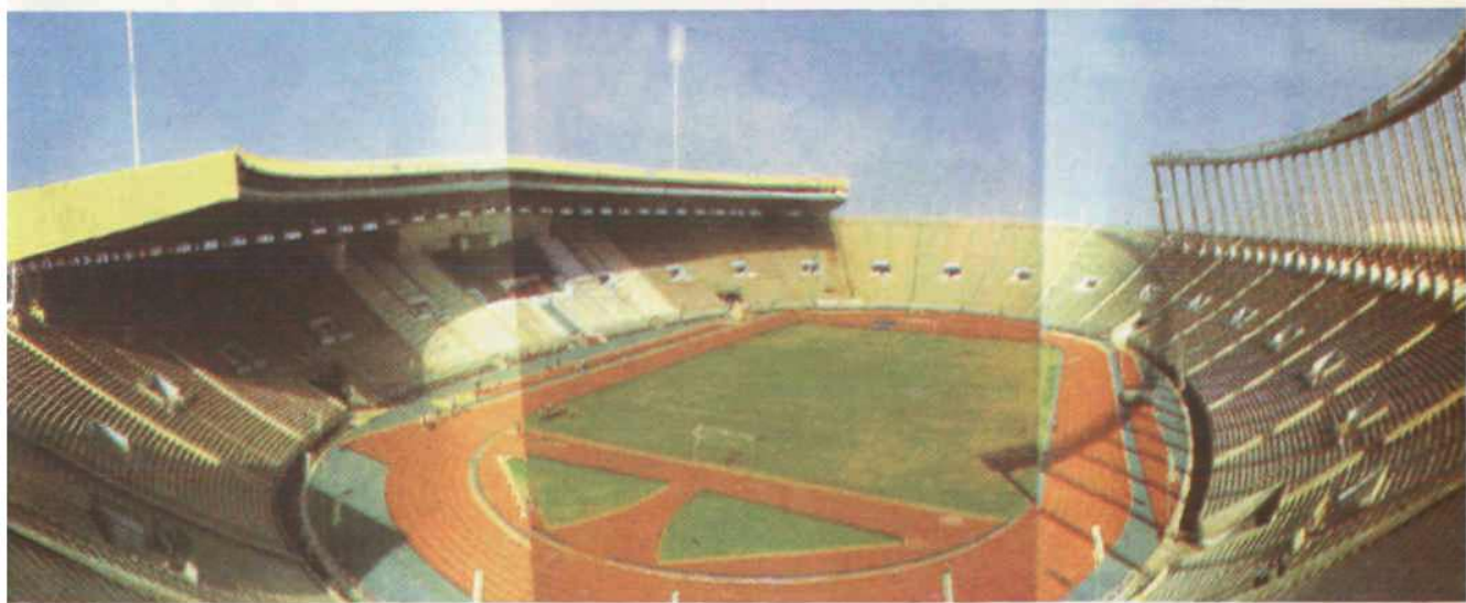
▲ 1990 年武汉承建的摩洛哥首都体育场工程全貌
