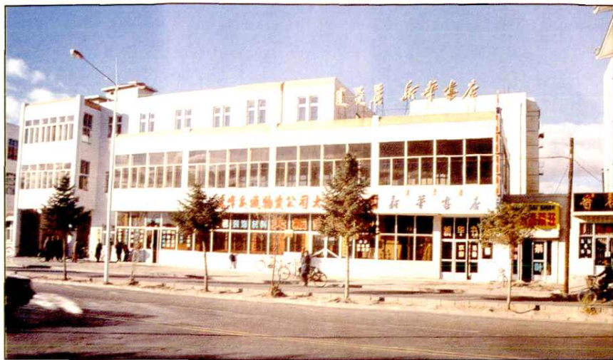
右旗支店大楼
