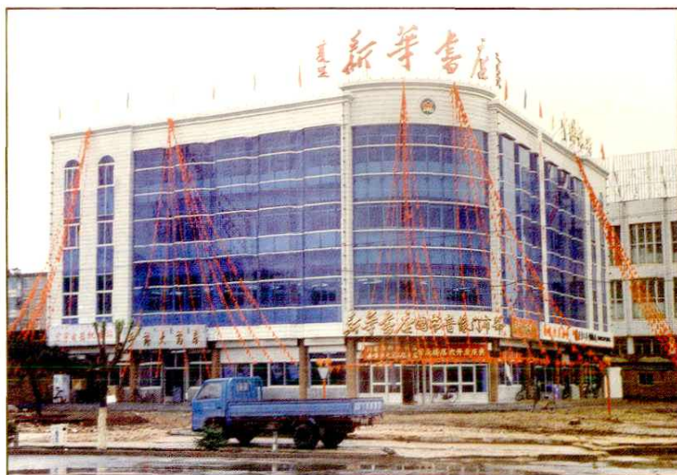
元宝山区支店大楼
