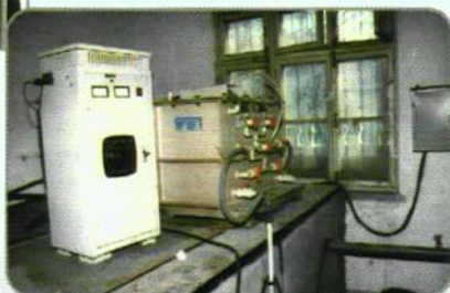
污水處理系統
